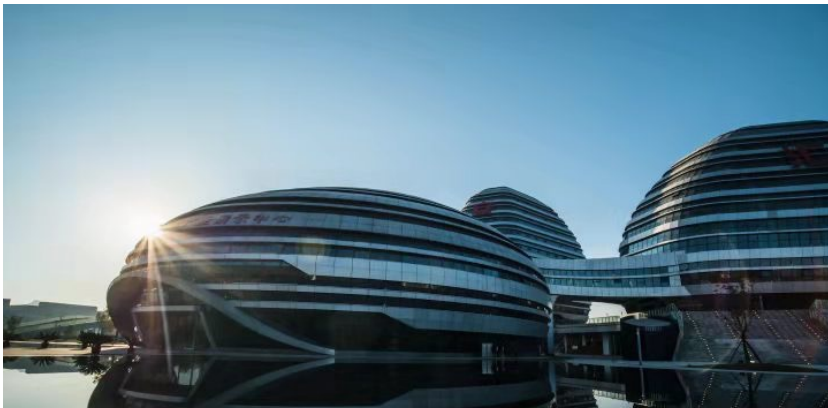
贵阳市大数据安全产业展示中心
